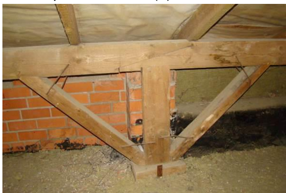
4.8.1 att. Jumta konstrukcijas malējie krēsli
