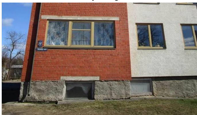
4.13.1 att. PVC un koka konstrukcijas logi
