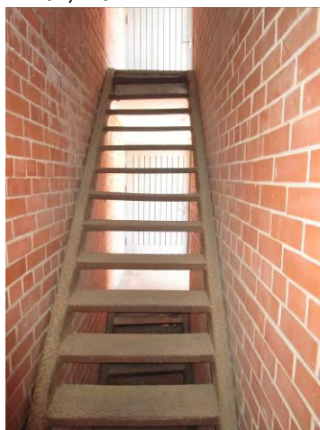
4.10.3 att. Ārējās tērauda kāpnes
