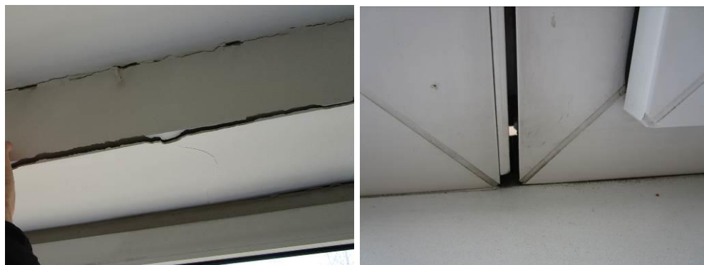
4.13.4 att. un 4.13.5. att Nekvalitatīva logu montāža un ailas apdare
