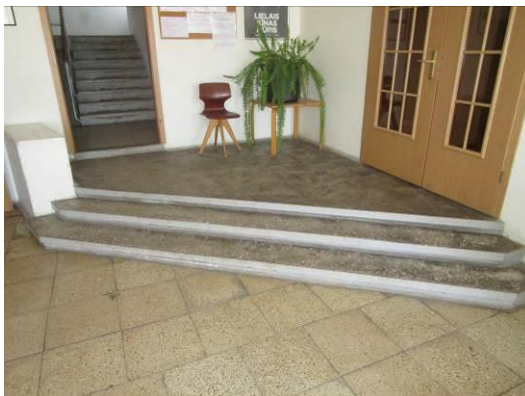
4.10.2 att. Halles monolītās betona kāpnes
