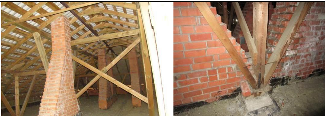
4.8.2 att. un 4.8.3 att. Jumta konstrukcijas vidējie krēslī
