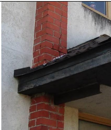
4.9.10. att. Plaisa nesošajā iekšsienā Iepriekš minētā lieveņa atbalstsienā konstatēta līdz 3mm plata plaisa.
