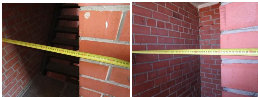
4.10.4 att. un 4.10.5 att. Ārējo tērauda kāpņu un ailas platums
