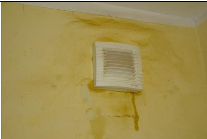
4.16.3 att. Nepareiza ventilācijas sistēmas ekspluatācija
