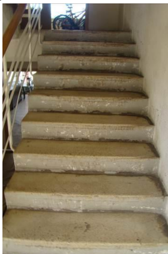
4.10.1 att. Saliekamā dzelzsbetona konstrukcijas kāpnes
