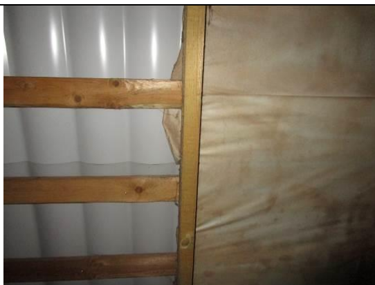
4.8.7 att. Daļēji ierīkotā pretkondensāta plēve
