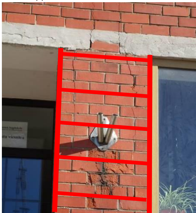
4.2.11. att. Mūra staba savilkšana (horizontāli tērauda loksnes, vertikāli lenķi)
