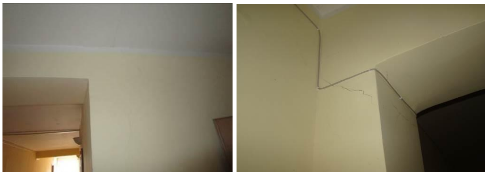
4.2.3 att. un 4.2.4. att. Plaisa ailu sijas balstījuma vietā
