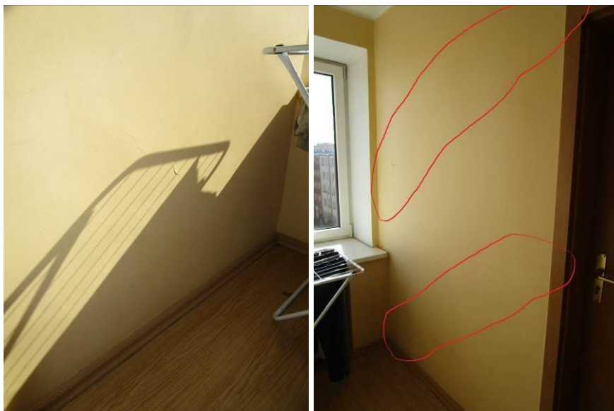
4.11.1 att. un 4.11.2. att. Deformācijas plaisas starpsienā
