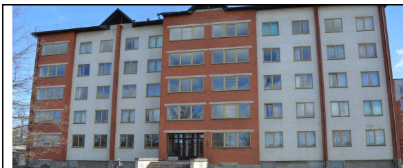
1.att. Ēkas dienvidrietumu fasāde
